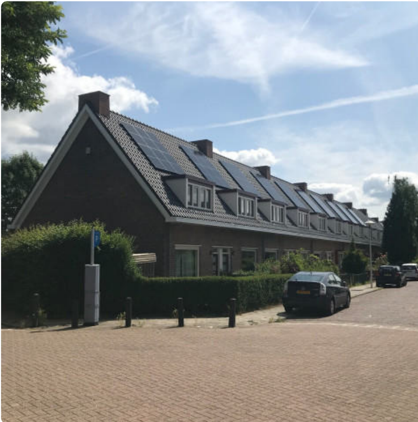
Zonnepanelen in Ondiep
