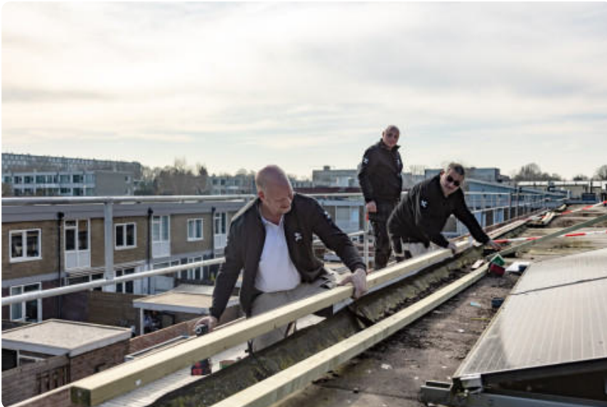
Groot onderhoud eengezinswoningen Overvecht
