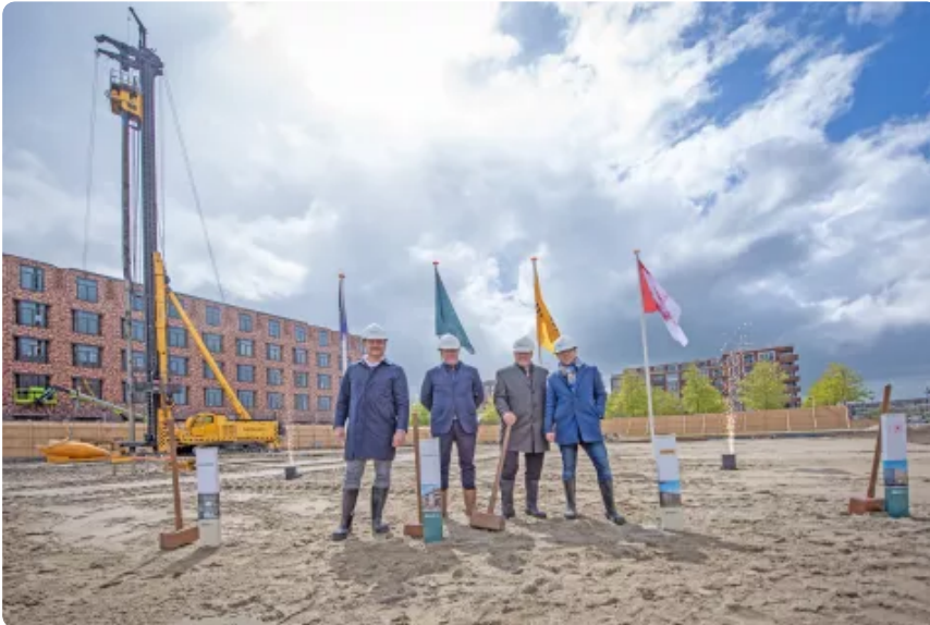
Start bouw Bloei030 (april 2024)
